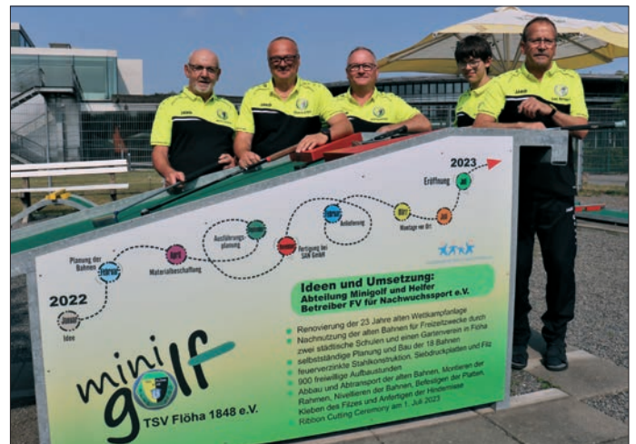
Das Team um Abteilungsleiter Thomas Engel (2.v.l.) hat die Sanierung der Minigolfanlage Flöha in Eigenregie erledigt. Foto: Knut Berger
